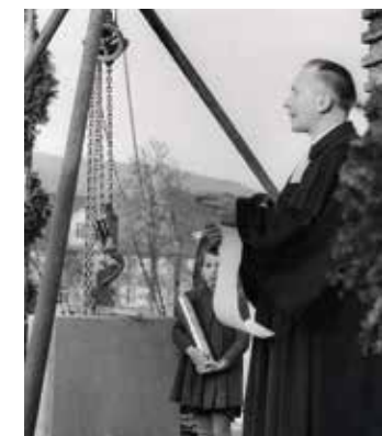
Pfarrer Alfred Böttcher bei der Grundsteinlegung 1953
