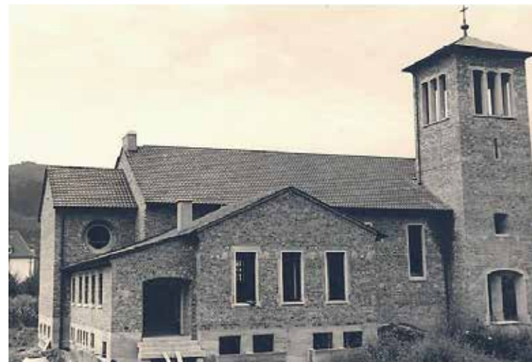
Der Rohbau der Kirche 1953
